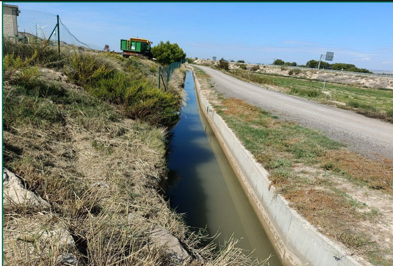
PUNTO DE AGUA Nº1
